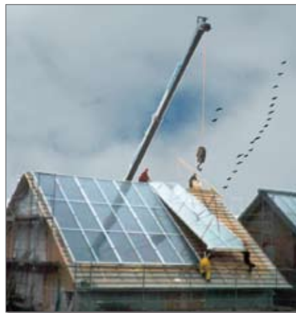
Foto: Montage der Solarkollektoren
