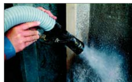
Foto: Aufbringung der Wärmedämmung mit Zelluloseflocken
