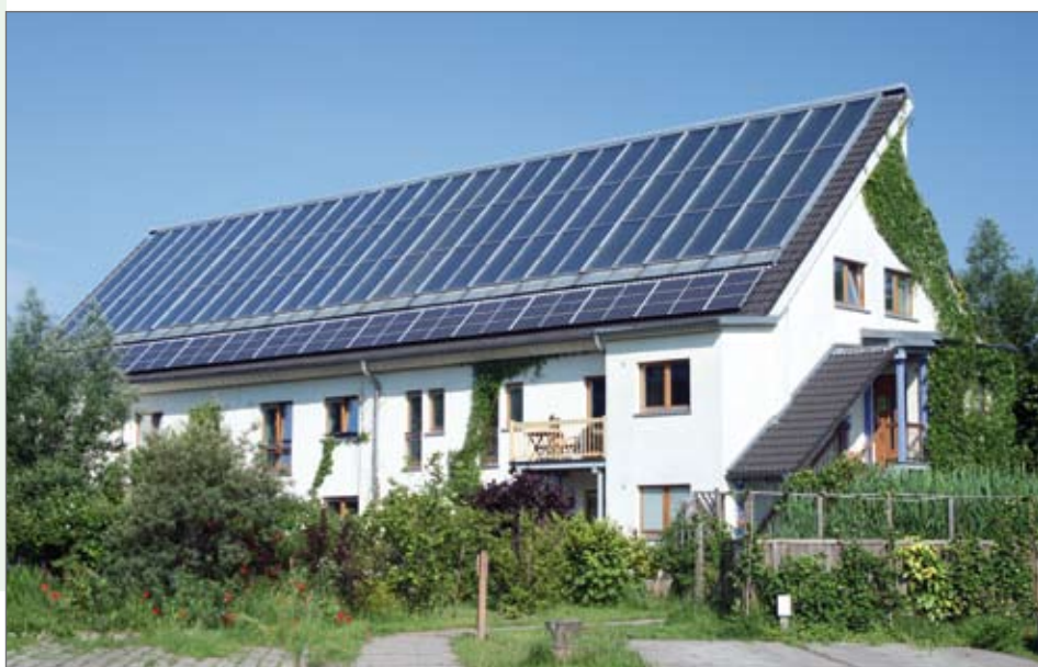
Foto: Solarkollektoren und PV-Module auf dem Süddach einer Häuserzeile
