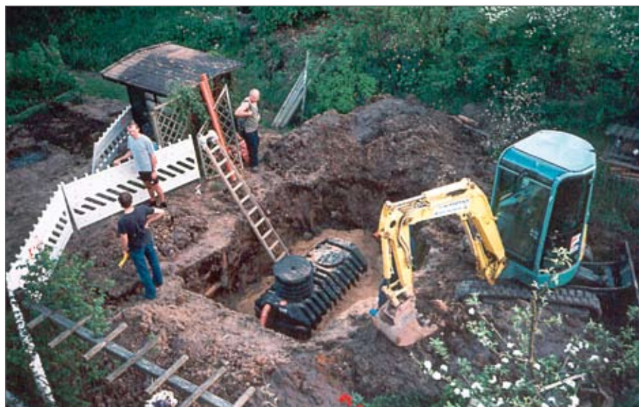
Foto: Einbau eines Regenwassertanks im Garten
