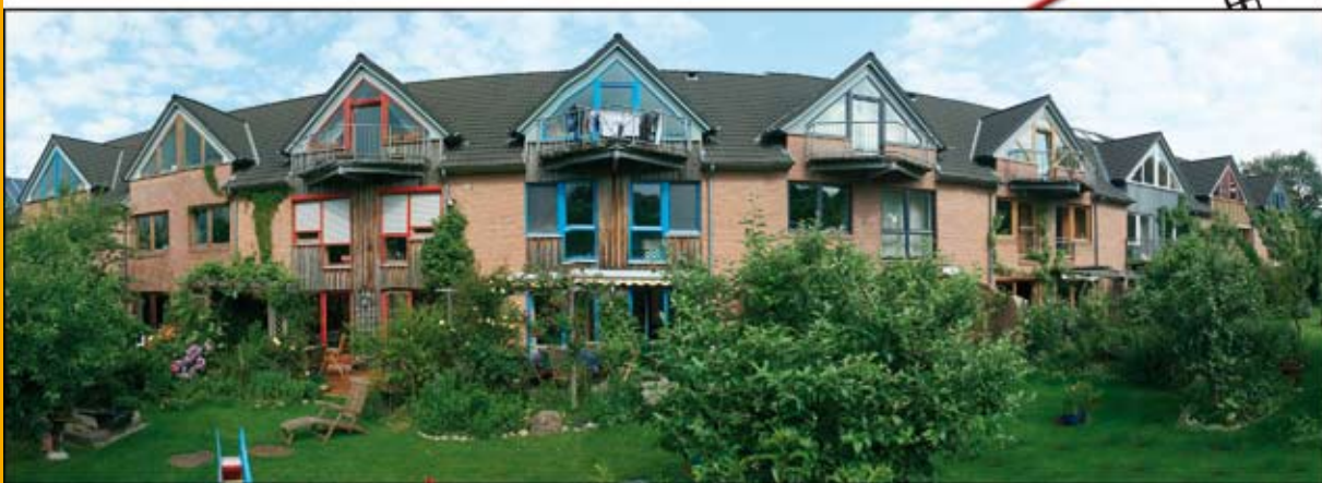
Zeile West: Neun Reihenhäuser wurden in Massivbauweise errichtet, zwei davon mit Kompost-toiletten, sieben mit Regenwasser-WC's, drei Häuser besitzen Lüftung mit Wärmerückgewinnung.
