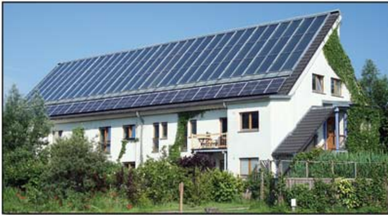
Wohnhof: zwei Reihenhauszeilen in Holzständerbauweise mit Kompost-toiletten, Lüftung ohne Wärmerückgewinnung und 50 m 2 Fotovoltaikmodulen.
